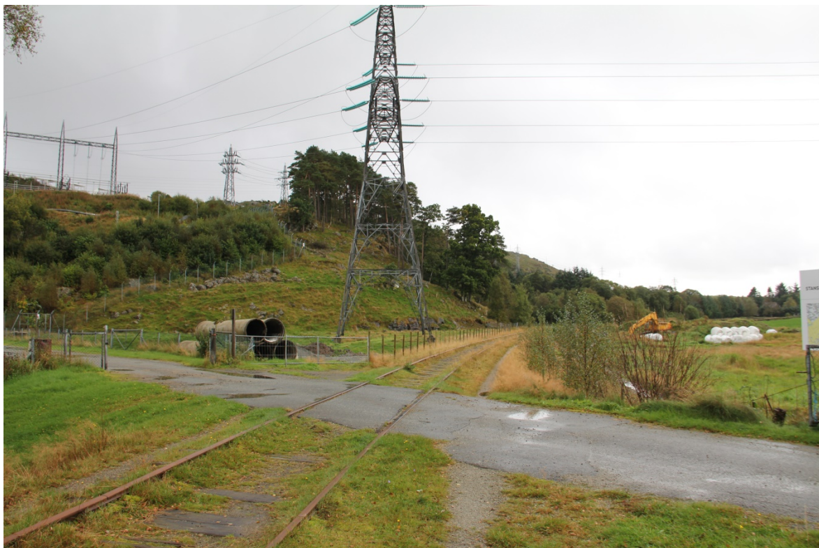
Figur 18. KM 2, Ålgårdbana. Partiet der linetraséén kryssar bana på Stokkeland. Mot sør.
