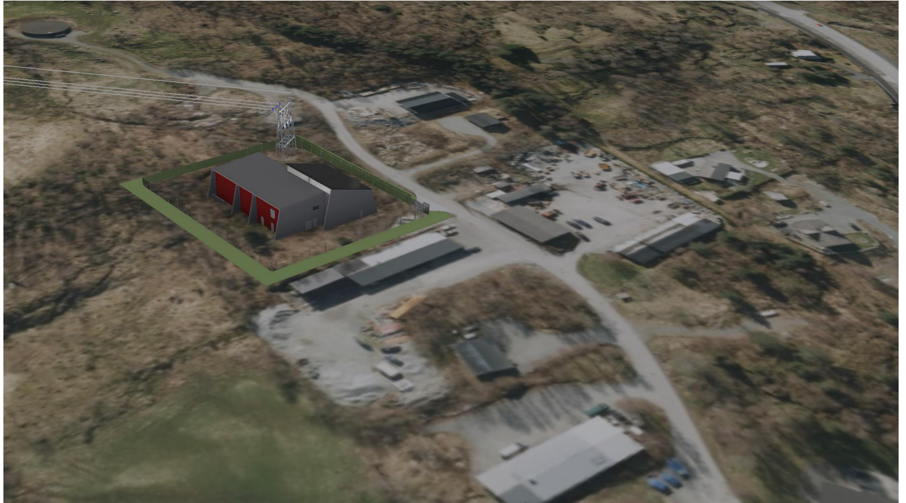
Nye Hjelmeland transformatorstasjon sett fra nord mot sør.
