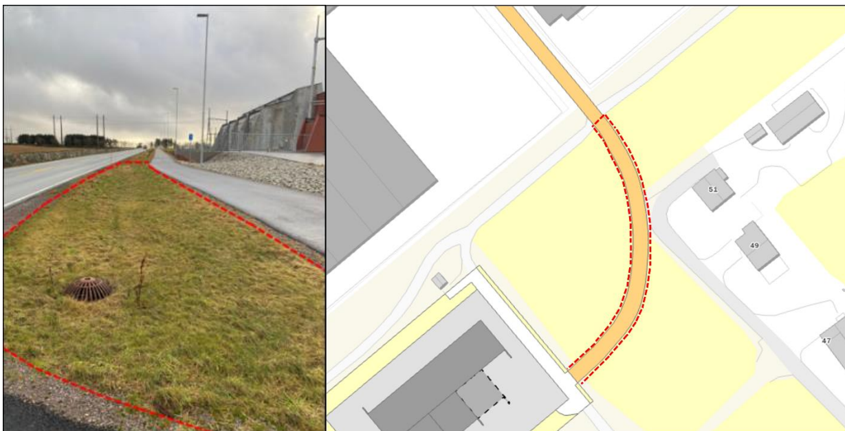
Figur 9 Bilde fra Opstad med gress over område tilrettelagt for spesialtransport (venstre) og område ved Tjora der gress over område for spesialtransport er aktuelt (høyre)
