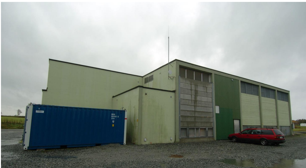
Figur 10 Eksisterende Risavika transformatorstasjon planlegges revet
