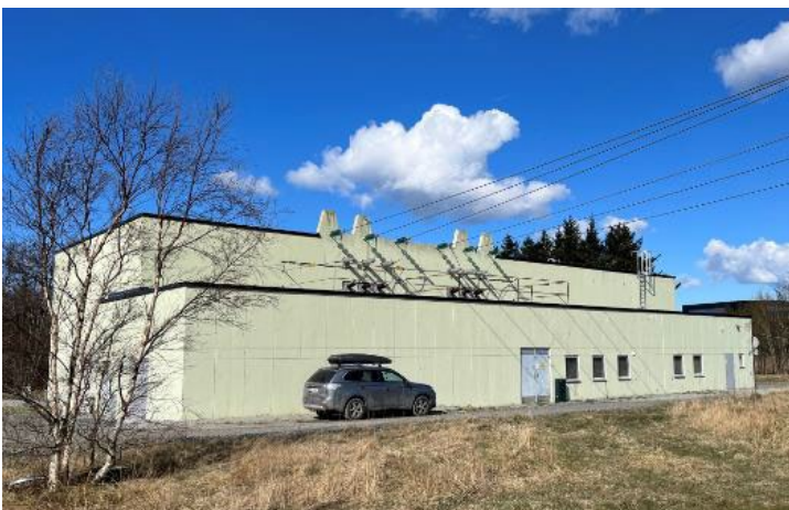
Figur 2-1 Risavika transformatorstasjon og endepunkt for luftledning Sande-Risavika (Foto: Multiconsult).
