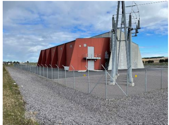
Figur 3-2 Anlegget på Tjora ligner bygg, endemast, gjerde og vedlikeholdssone på Opstad transformatorstasjon (Multiconsult).
