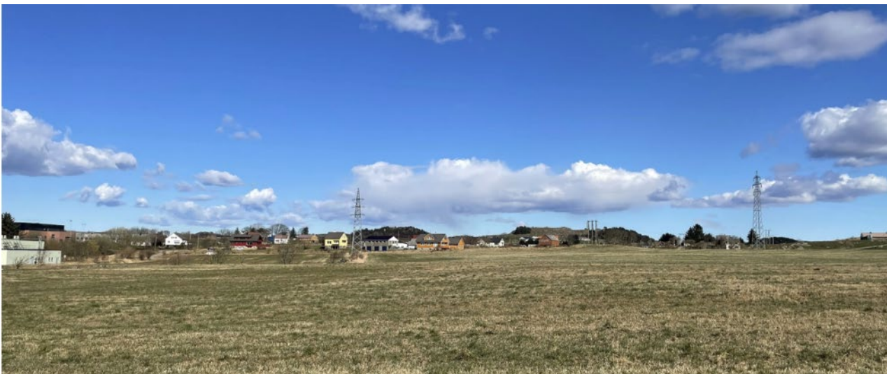
Figur 5-5 Luftledning til Risavika transformatorstasjon, sett mot nord (Foto: Multiconsult).
