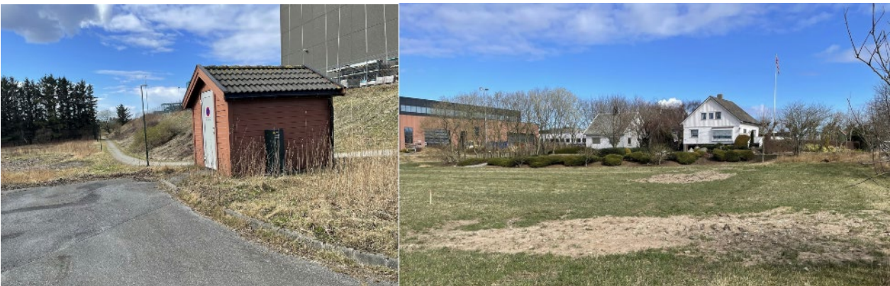
Figur 5-4 Til venstre, kommunalt pumpehus og le-beplantning ved tomt 1, sett mot sørvest. Til høyre, bebyggelse ved tomt 4a og 4b, sett mot nordøst (Foto: Multiconsult).
