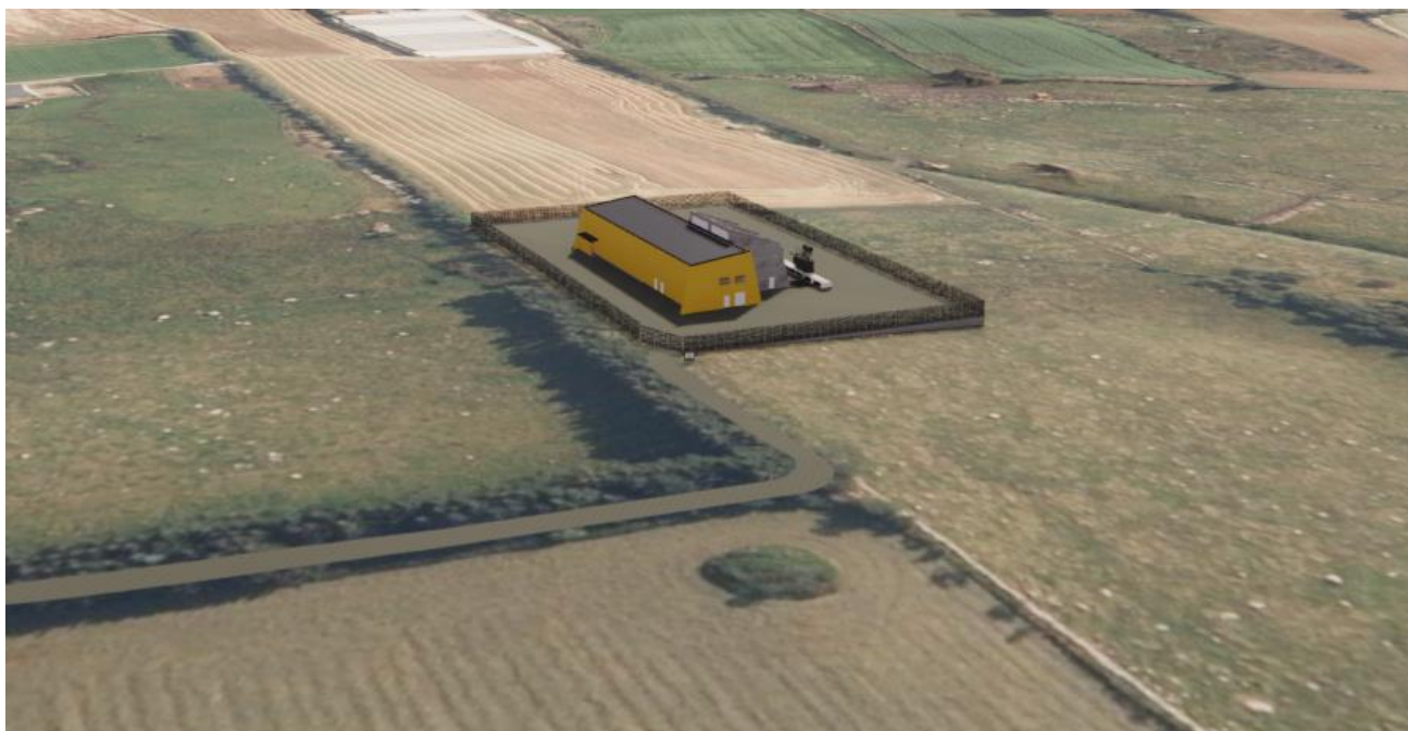
Figur 4 Tjøtta transformatorstasjon - sett fra vest
