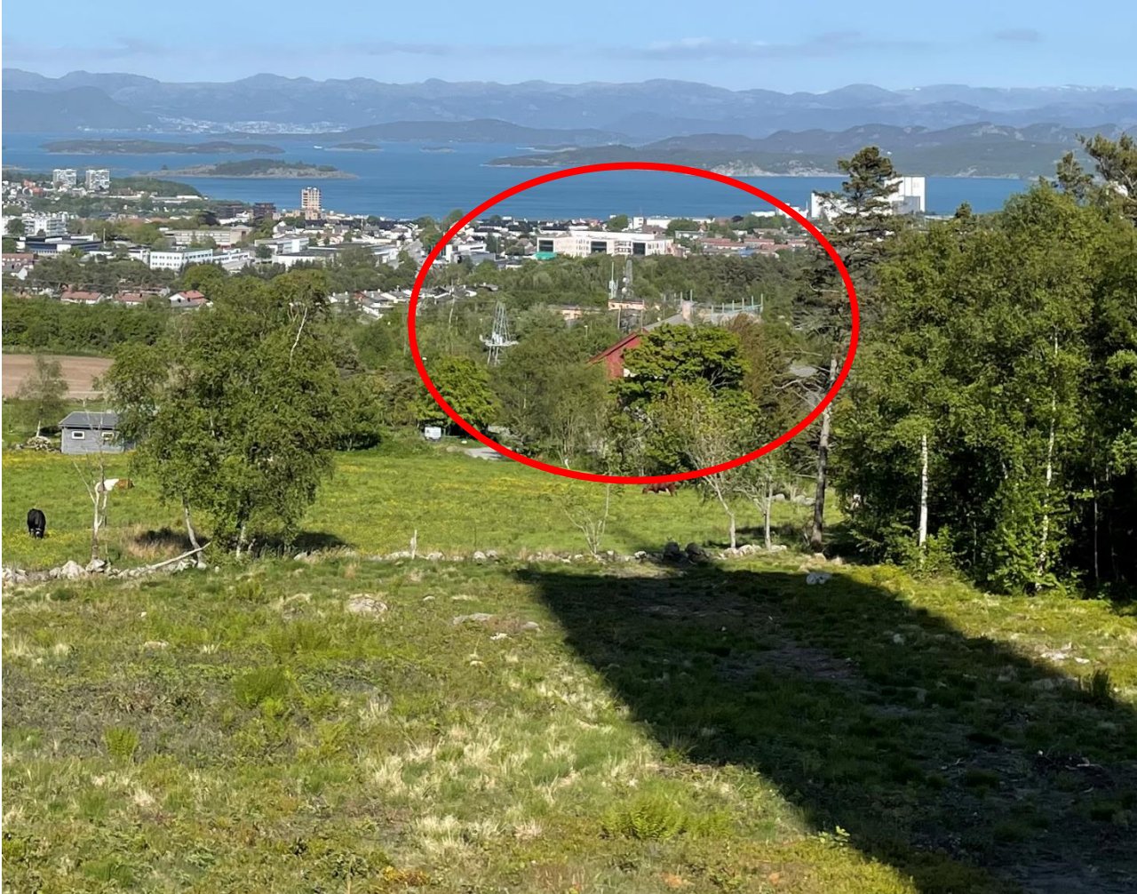
Figur 13 Utsikt fra Ullandhaugtårnet mot Ullandhaug transformatorstasjon, innringet (foto: Lnett, 1. juni 2023)
