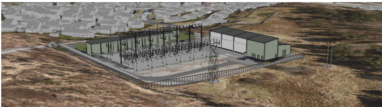
Figur 3 Ullandhaug transformatorstasjon med nytt frittstående bygg til høyre
